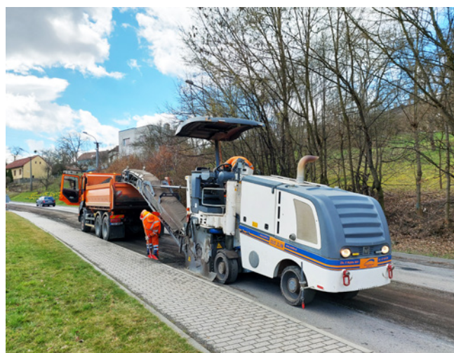
Fréza Wirtgen W 100i, šířka 100 cm
