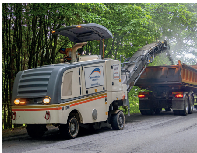
Fréza Wirtgen W 100i, šířka 100 cm
