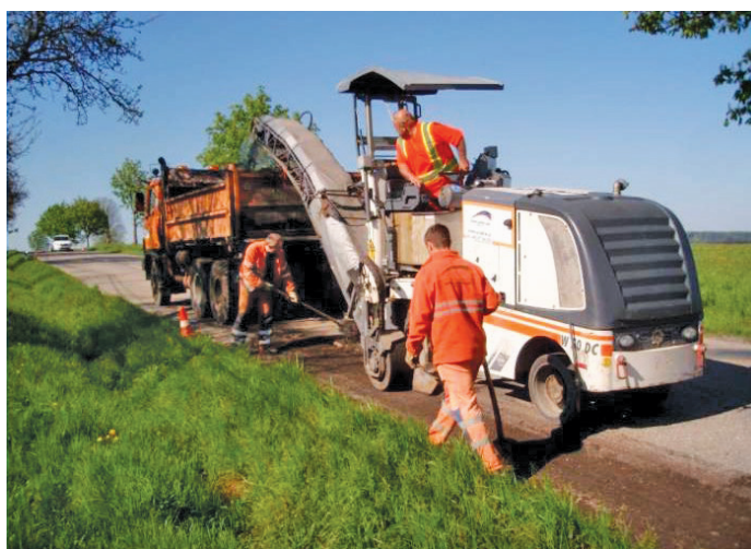
Fréza Wirtgen DC 50, šířka 50 cm
