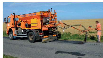
Vysprávký turbomechanismem
