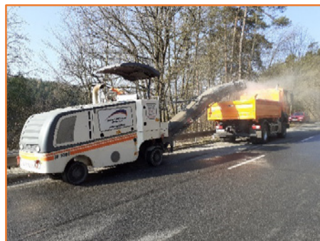
fréza Wirtgen W 100i, šířka 100 cm
