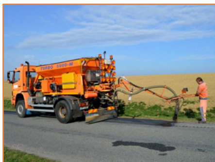
vysprávký turbomechanismem
