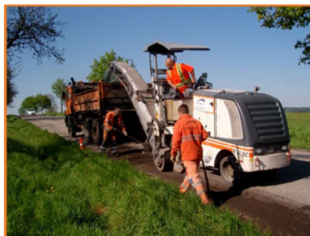
fréza Wirtgen DC 50, šířka 50 cm
